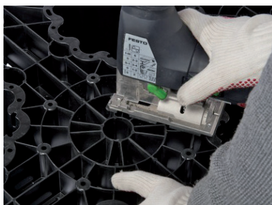
Izrada otvora na polublokovima za inspeksijske priključke
