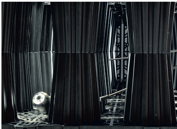
Kamera sa potisnim kablom (tzv. crv)
