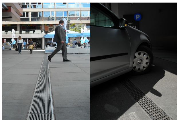
ACO MultiDrain kanali na trgu ispred objekta i na ulazu u garažu
