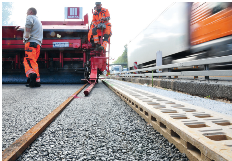
ACO DRAIN® Monoblock RD 200 V DF na autoputu A1, Hamburg
