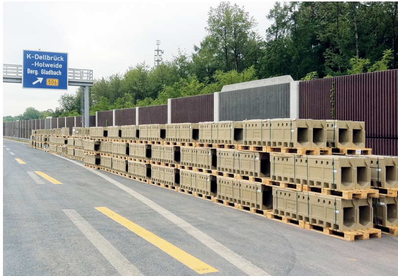
ACO DRAIN® Monoblock RD 300 DF ugradnja na autoputu A3
