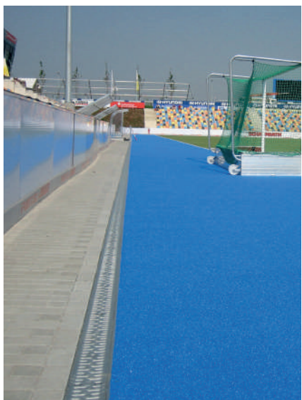
ACO Sport® 6000 je kanal svjetlog otvora 100 mm, sa profilom za ukliještenje umjetne trave, izrađen od polimerbetona. Pokrovna rešetka sadrži Quicklock zaključavanje za kanal i sabirnik.
