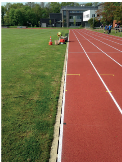
ACO Sport® 1500 je kanal sa šlicem svjetlog otvora 125 mm, izrađen od polimerbetona
