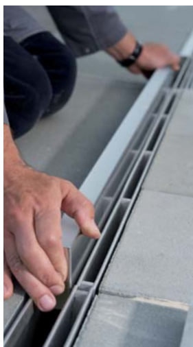
Ugradnja LED elemenata u šlic ram
