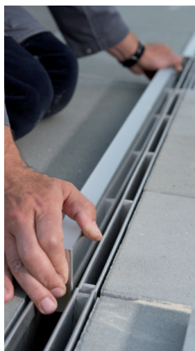
Ugradnja LED elemenata u šlic ram
