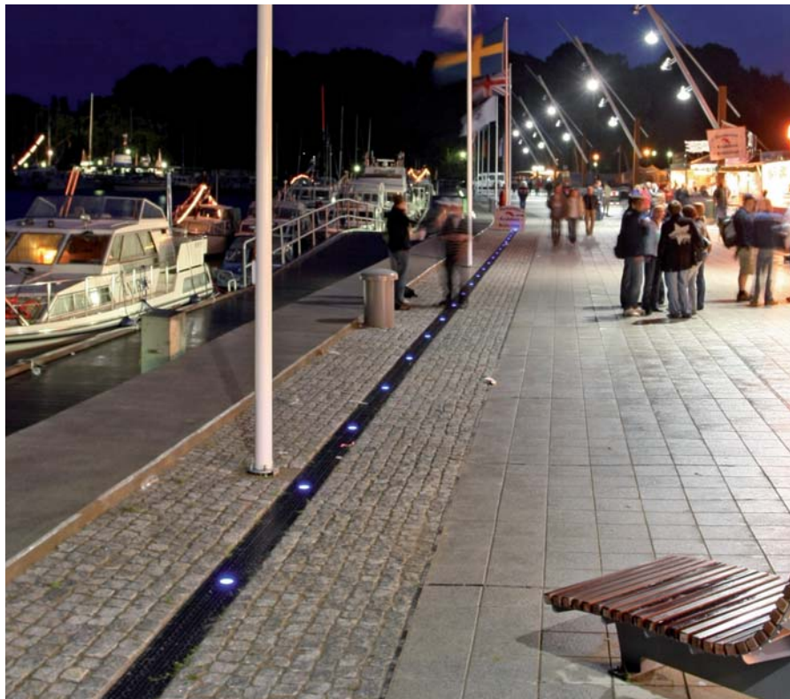
ACO Lightpoint kao kombinacija odvodnje i osvjetljenja; pristanište Obereider u Rendsburgu, Njemačka.
