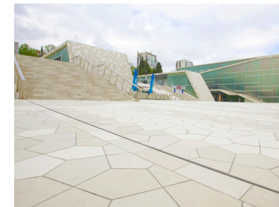
CENTAR ZAMET, Rijeka, Hrvatska ACO DRAIN® Multiline sa šlic rešetkom
